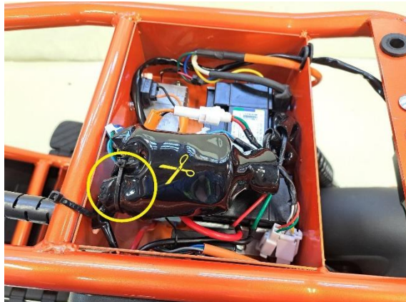
Katkaise johtojen suojaa kiinni pitävä nippuside (sivuleikkurit).
